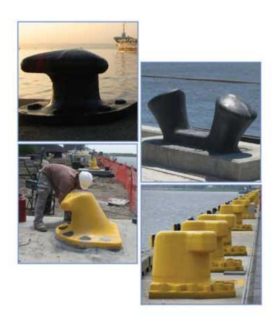
هدف از بکارگیری بولارد نگه داشتن شناور در محل پهلوگیری و پیشگیری از دور شدن آن با استفاده از خطوط مهاربندی می باشد. معمولا یک شناور توسط ۲ تا ۸ خط مهار کنترل می شود که این بولارد ها بایستی بتوانند نیروی مهار بندی را در زاویه مهار تحمل نمایند.
